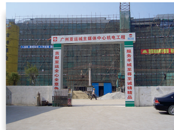
亚运主媒体中心机电工程
